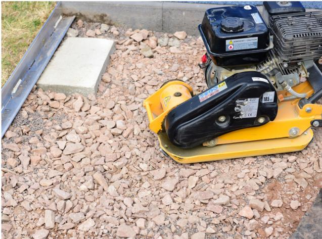
Die Konstruktion ist mit einer umlaufenden, tragfähigen, festen Randeinfassung zu versehen (z. B. Randsteine in Fundament aus Sopro Rapidur® M8). Die Schotterschicht gewährleistet die Frostsicherheit, ist mind. 30 cm dick auszuführen und lagenweise zu verdichten, um Setzungen zu vermeiden. Die Schotterschicht muss dabei bereits ein ausreichendes Gefälle aufweisen.
