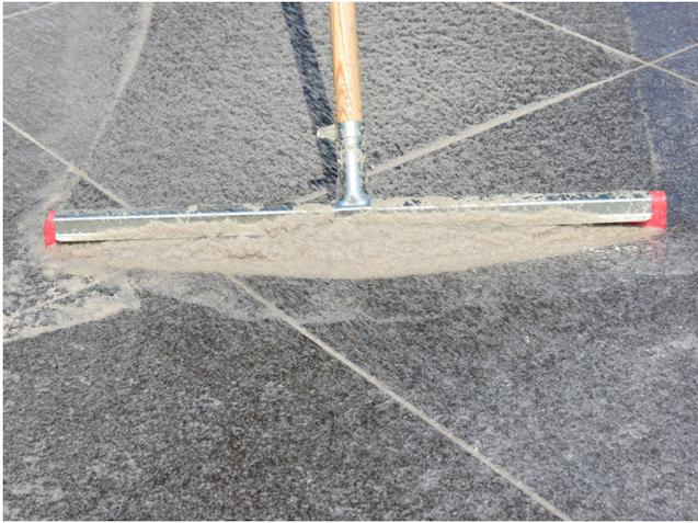
... und mittels Gummischieber in die Fuge einbringen.
