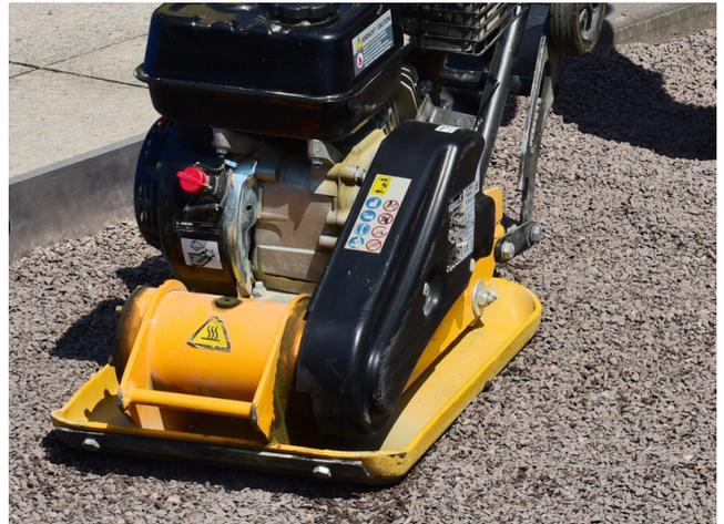
Nach dem Herstellen der Tragschicht wird eine dünne Lage (~10 – 20 mm) aus filterstabilem, scharfkantigem Splitt in der Korngröße (2/5) über der gesamten Fläche verteilt und mit einer Rüttelplatte zum gründlichen Verschließen von Hohlräumen in der Tragschicht kompaktiert.
